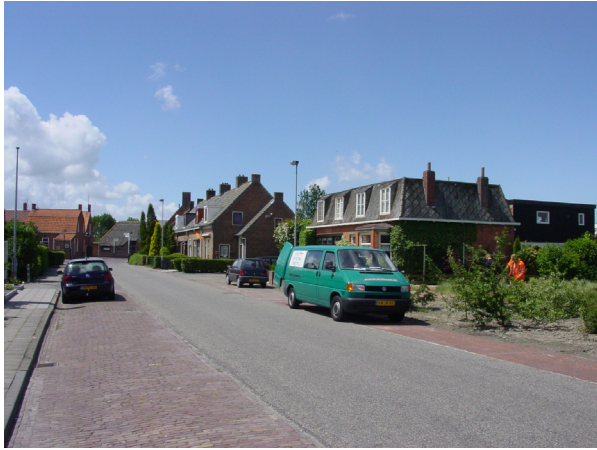
Afbeelding 22: uitvoering van een boring.
