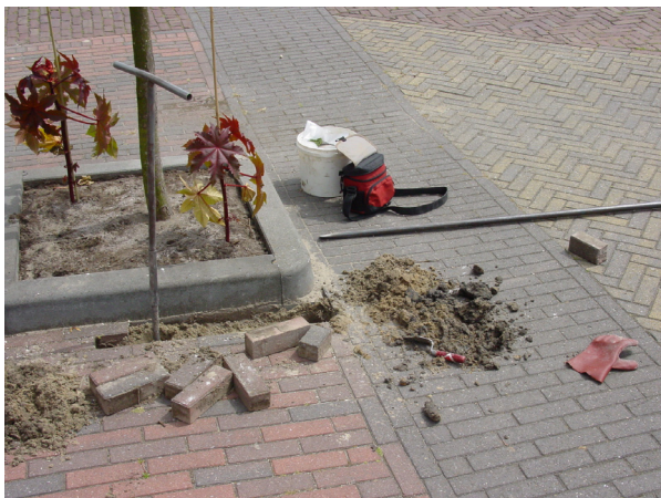
Afbeelding 24: uitvoering van een boring.
